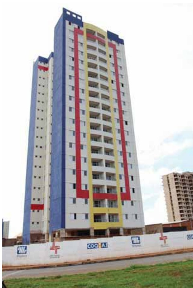
Bloco A do Residencial Imprensa III, em fase de acabamento
