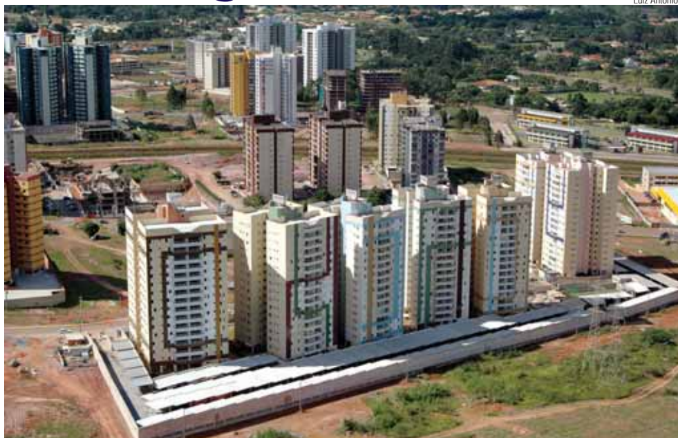
Residencial Imprensa I, concluído
