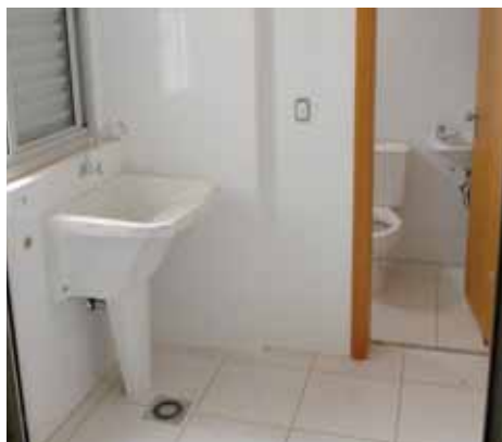
Louças da área de serviço e banheiro
