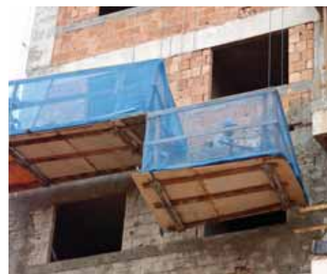
Chapisco da fachada
