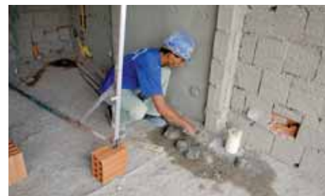
Execução dos contrapisos
