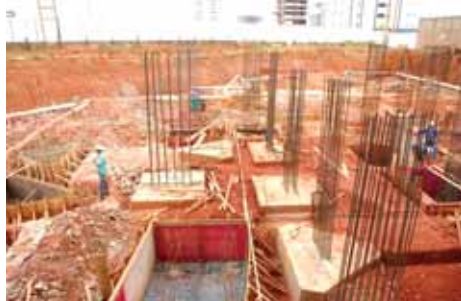
Blocos das fundações
