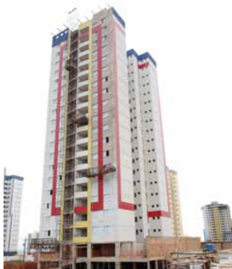
Acabamento da fachada
