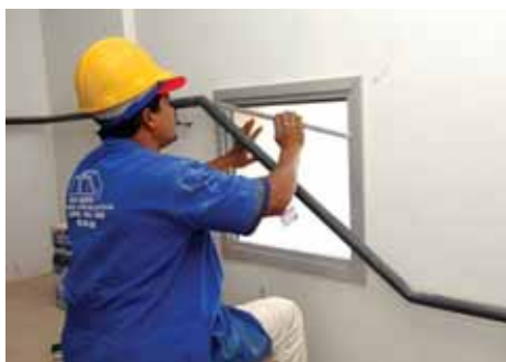
Colocação de vidros
