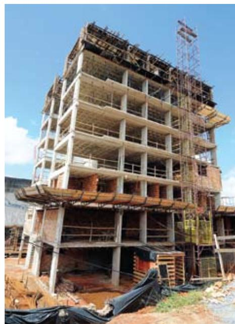
Após a conclusão da 8ª laje da projeção do prédio, o cronograma da construtora prevê o término da estrutura de concreto para o mês de julho. No momento está em execução a laje do subsolo, que ocupa toda a área do terreno, destinada a vagas de garagens. Também em andamento as alvenarias, tendo sido edificadas as do térreo, primeiro e segundo pavimentos-tipo.
