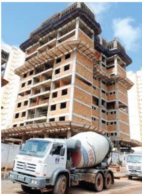
**BLOCO D** – No dia 25 foi executada a 12ª e para o dia 31 foi programada a 13ª, prevenindo-se a conclusão de toda a estrutura para o final de maio. As alvenarias atingiram o 8º pavimento. Imediatamente se iniciará as instalações das tubulações elétricas e hidráulicas e os contrapisos.
