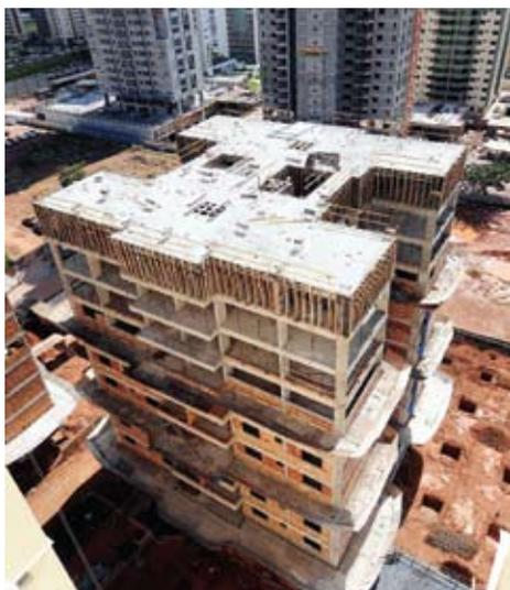
**BLOCO C** – Já foram executadas onze lajes, as alvenarias encontram-se no sétimo pavimento e o chapisco interno está no quinto. O Consórcio programou a conclusão da estrutura de concreto para o final de maio.
