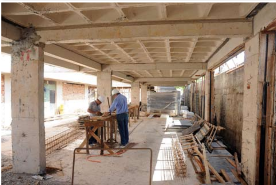
Preparação de estruturas de aço
